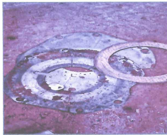
IMAGEM DETALHADA DE PLACAS DANIFICADAS
